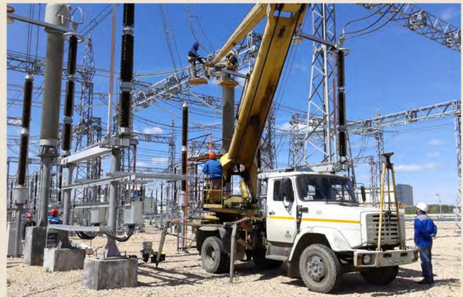
*Проверка измерительных трансформаторов тока 500 кВ*
